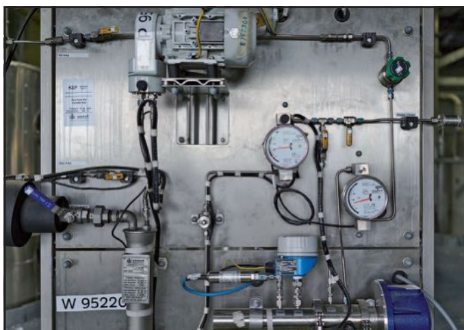
A robbanásveszély miatt folyamatosan figyelik a gyártórendszer oxigénszintjét
